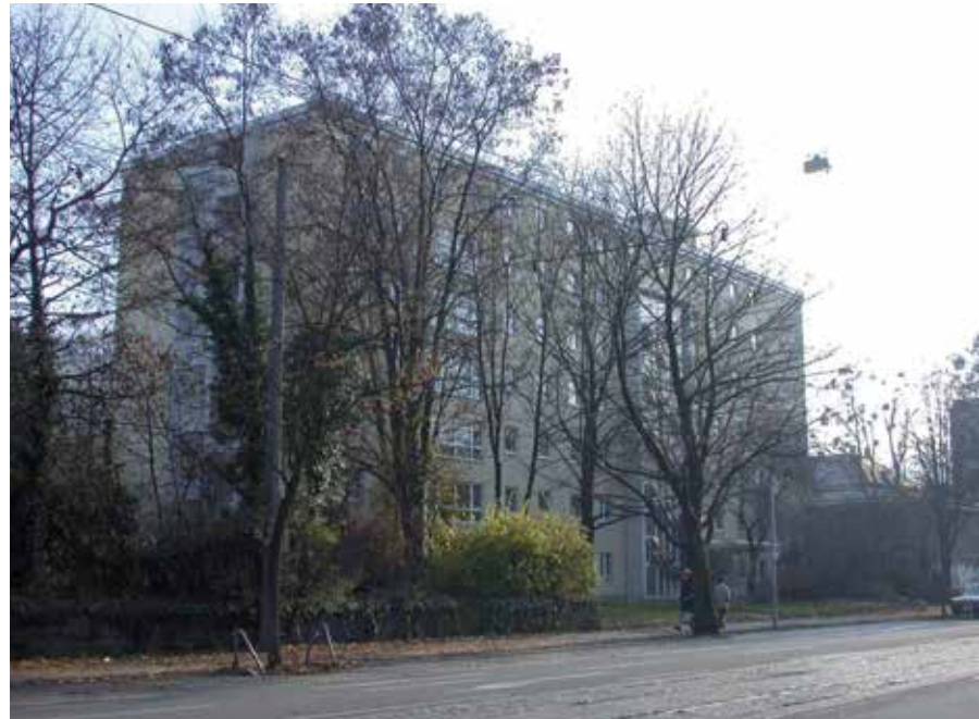
St. Georg vor dem Abbruch
