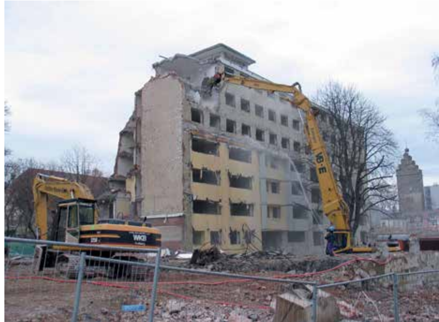
St. Georg während des Abbruchs
